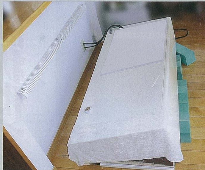
上の写真は重さが250kg以上あるタイプ。下地板に施工していた転倒防止金具から外れて倒れた。前面パネルが開いて内部のレンガが飛び出した。メーカーの対応が遅れたため、1カ月半以上倒れたままになった。左は2階に設置していた小型のタイプ。転倒防止金具から外れて前にずれた。故障はしていなかった
