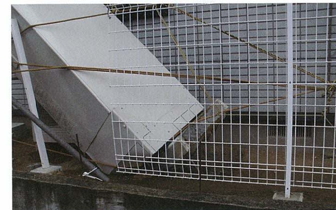
左の写真はプレキャストコンクリート製の基礎ブロックで固定していた貯湯タンクが、基礎ブロックごと浮き上がった例。場所は宮城県内。右上は4本足で固定されている薄型の貯湯タンク。場所は茨城県内。右下は現場打ちしたコンクリート基礎に固定していた例。直径12mmのアンカーボルトが抜けて転倒した。触れ止め金具も外れた。場所は仙台市内
