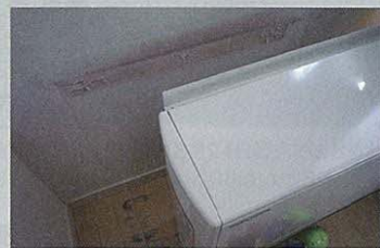
上の写真は重さが250kg以上あるタイプ。下地板に施工していた転倒防止金具から外れて倒れた。前面パネルが開いて内部のレンガが飛び出した。メーカーの対応が遅れたため、1カ月半以上倒れたままになった。左は2階に設置していた小型のタイプ。転倒防止金具から外れて前にずれた。故障はしていなかった
