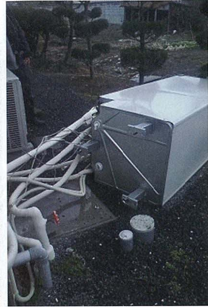
左の写真は地震で転倒し、足が変形した貯湯タンク。場所は仙台市内。右の写真は現場打ちコンクリートの基礎に設置してあった貯湯タンク。アンカーが3本とも抜けていた。場所は宮城県内。東北地方では、配管などの部品が凍結して破損する被害も発生した。3月の寒い時期に地震の影響で長期間停電が続き、凍結防止機能が止まったためだ
