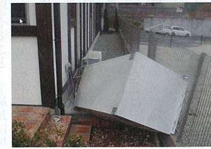
左の写真はプレキャストコンクリート製の基礎ブロックで固定していた貯湯タンクが、基礎ブロックごと浮き上がった例。場所は宮城県内。右上は4本足で固定されている薄型の貯湯タンク。場所は茨城県内。右下は現場打ちしたコンクリート基礎に固定していた例。直径12mmのアンカーボルトが抜けて転倒した。触れ止め金具も外れた。場所は仙台市内
