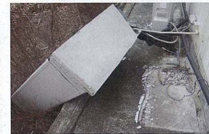
左の写真は地震で転倒し、足が変形した貯湯タンク。場所は仙台市内。右の写真は現場打ちコンクリートの基礎に設置してあった貯湯タンク。アンカーが3本とも抜けていた。場所は宮城県内。東北地方では、配管などの部品が凍結して破損する被害も発生した。3月の寒い時期に地震の影響で長期間停電が続き、凍結防止機能が止まったためだ
